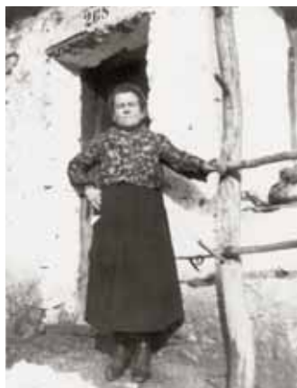
La proprietaria di Maso Fratton, Giulia Viola in Endrizzi, sull'ingresso (anni '50)
