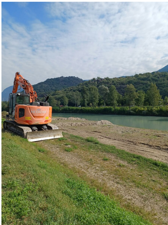
Foto 1. Escavatore cingolato in opera sul ciglio di sponda; la fascia golenale è stata scoticata fino al filo dell'acqua.
