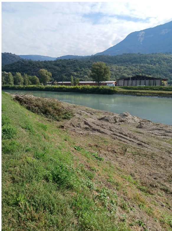
Foto 3. Vista verso monte: golena scoticata e cumuli di terreno lungo la sponda.
